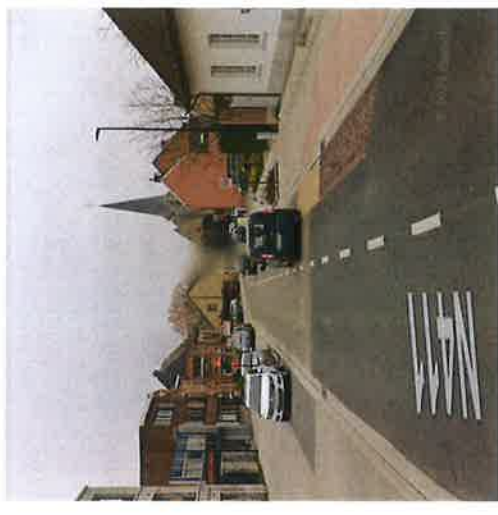
Overrijdbare punctuele wegversmalling (Bv. Printasfalt (kassei))
