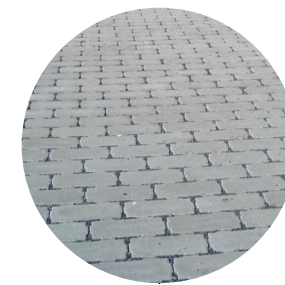
woonerf waterpasserende straatstenen
